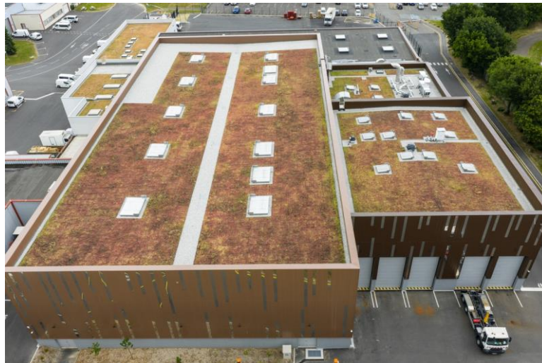
Toiture végétalisée © C. Le Potier
